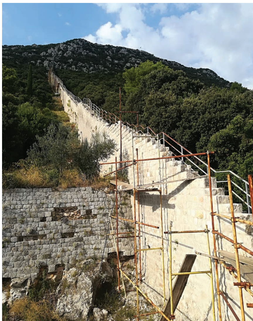
Detalj rekonstrukcije zida
