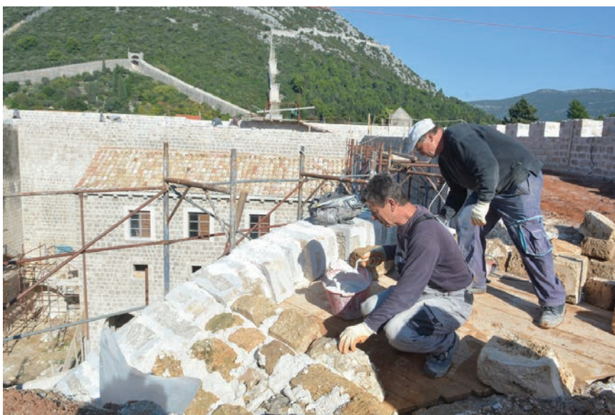
Detalj s gradilišta
