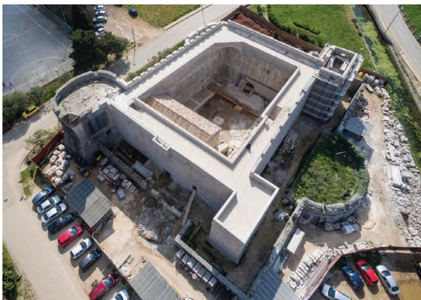
Tvrđava Veliki Kaštio, pogled iz zraka
