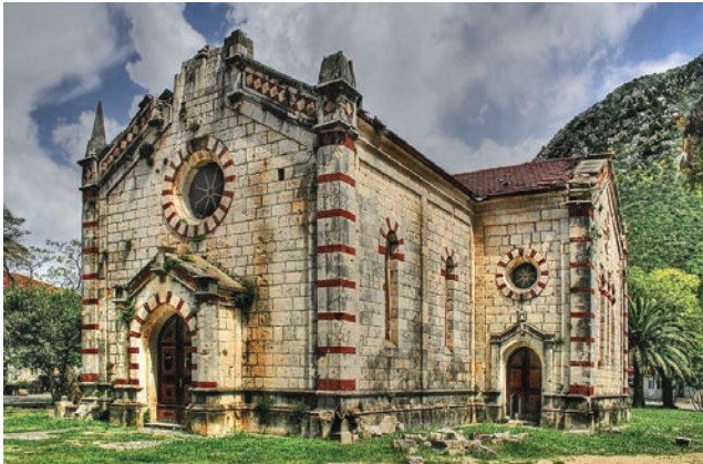
Crkva sv. Vlaha prije obnove, oštećena u jakom potresu 1996.
